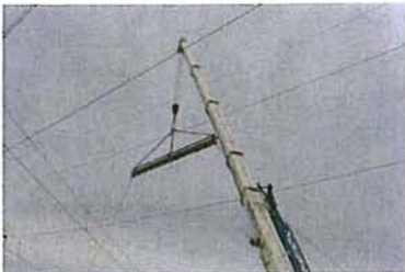
Bild 3) Einschwenken und Anheben der Schutztraverse
