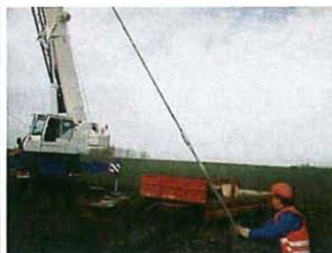
Bild 6) Zurückziehen Leiterseil, straffhalten mit spannungsfestem Seil
