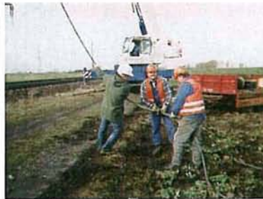
Bild 5) Ankoppeln des spannungsfesten Seiles
