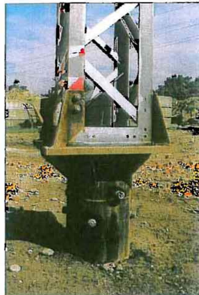
Bild 4. Adapterstück zwischen Rammrohr und Baukastenschuß
