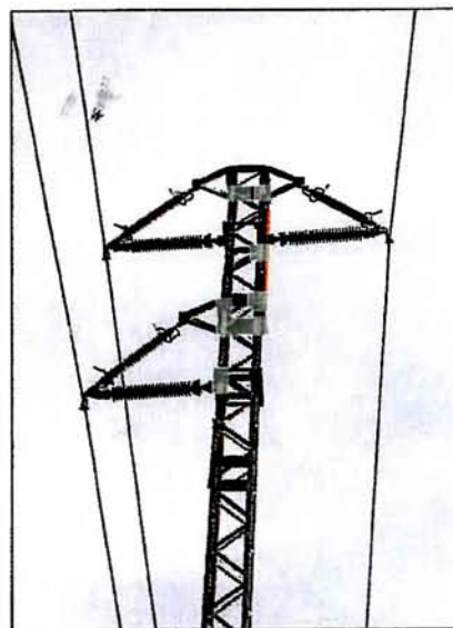
Bild 5. Isoliertraversen an freistehenden Tragmasten
